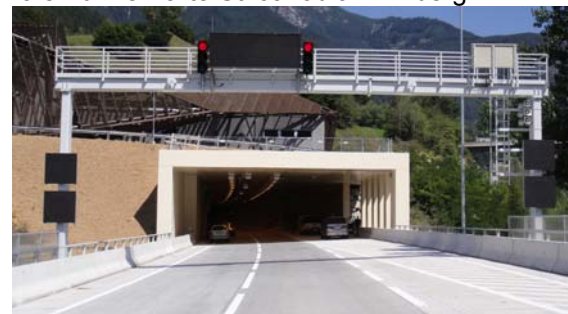
Der Tunneleingang: Einfahrt in die Südröhre
