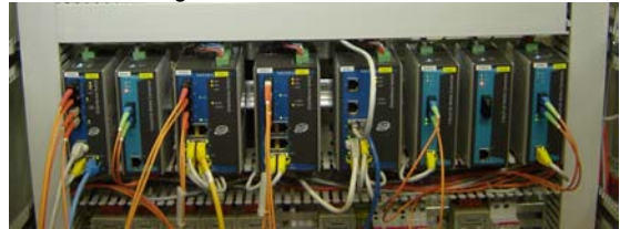
Abb. 2: Einfache Montage der Switches dank Haltevorrichtung
