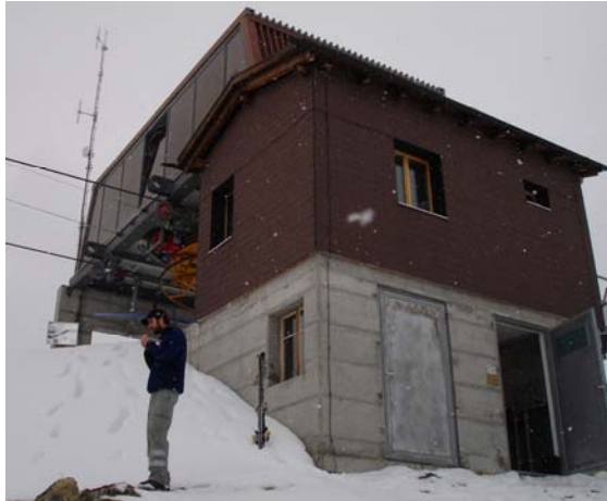
Die Antenne bei der Bergstation Disentis: ein Richtfunk unten und zwei Funkantennen oben
