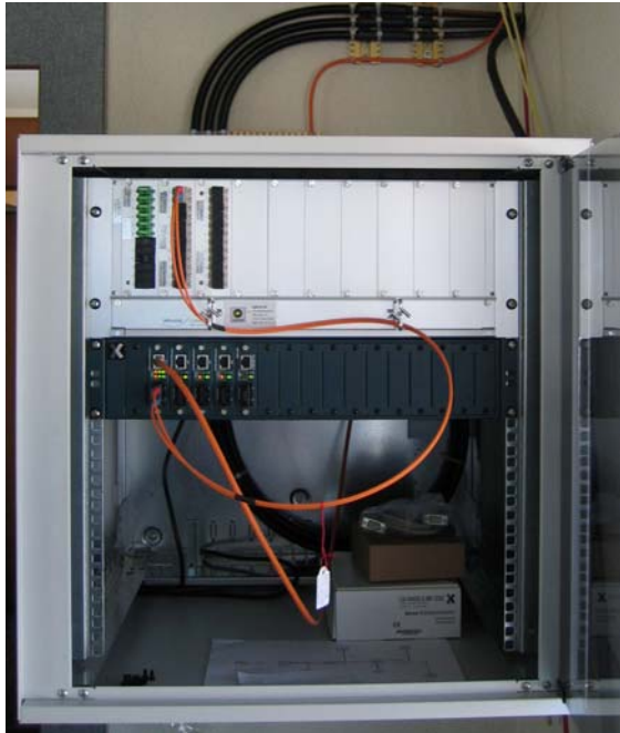
Répartiteur Fast Ethernet Singlemode du Sternegg Tal
